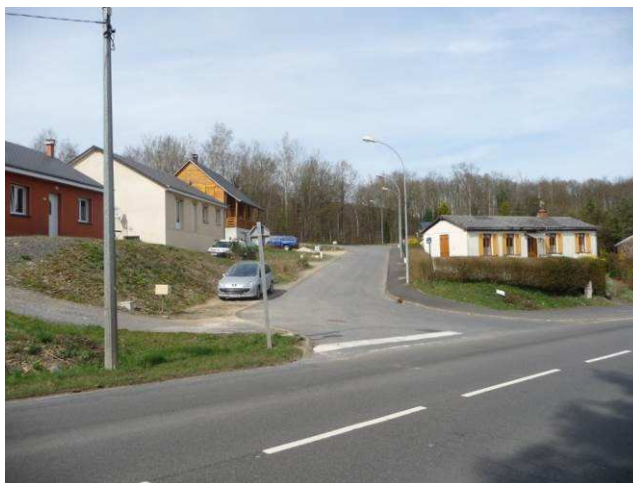
Lotissement en construction à l'entrée de ville via la RD.8051
