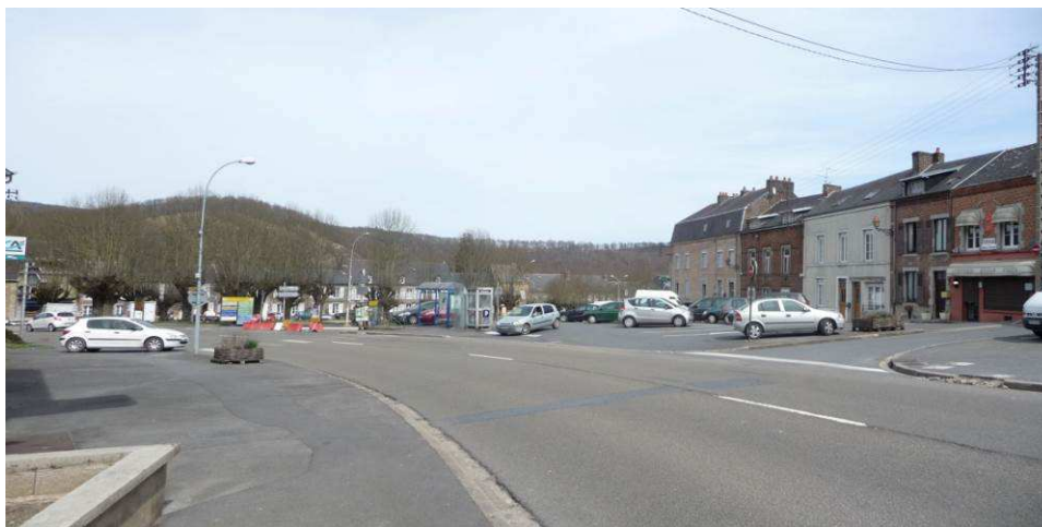
Vue sur la place d'Auchel (avant réaménagement)
