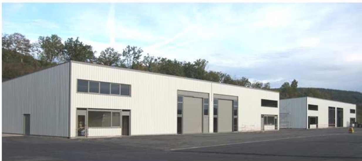
Source : © www.ardennesrivesdemeuse.com (Bâtiment artisanal de Fumay)
